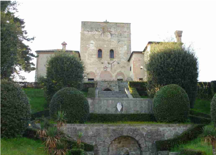
La torre centrale del Castello del Mottolo
