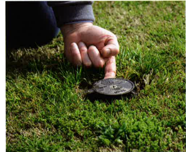
Il dettaglio di uno dei 1200 erogatori mimetizzati nel green
