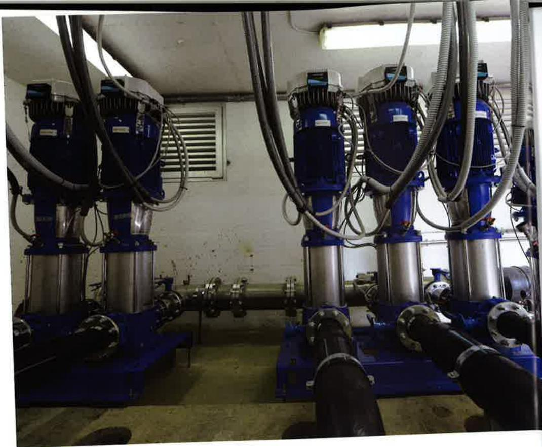
**Il nuovo gruppo di pompaggio composto da sei elettropompe multistadio verticali della serie e-SV. Quattro elettropompe sono di servizio, una di riserva e una pilota per le piccole esigenze idriche e per l'approvvigionamento invernale**
