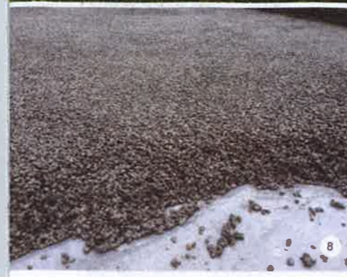
FOTO 5. Flow-layer realizzato con la stesa di manto MAPEPLAN PE. FOTO 6. Scarico sull'area del bunker della miscela drenante di MAPESOIL GF. FOTO 7. Stesa della miscela drenante di ghiaietto VG SPORT GU 6 e MAPESOIL GF. FOTO 8. Dettaglio della miscela drenante confezionata con MAPESOIL GF.
