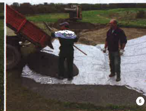
FOTO 5. Flow-layer realizzato con la stesa di manto MAPEPLAN PE. FOTO 6. Scarico sull'area del bunker della miscela drenante di MAPESOIL GF. FOTO 7. Stesa della miscela drenante di ghiaietto VG SPORT GU 6 e MAPESOIL GF. FOTO 8. Dettaglio della miscela drenante confezionata con MAPESOIL GF.
